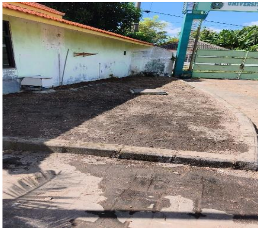
Gambar 3. Tahap Persiapan Akhir Lokasi
